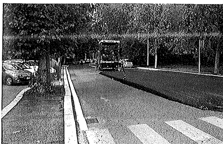
3. Lavori stradali in ambito urbano
